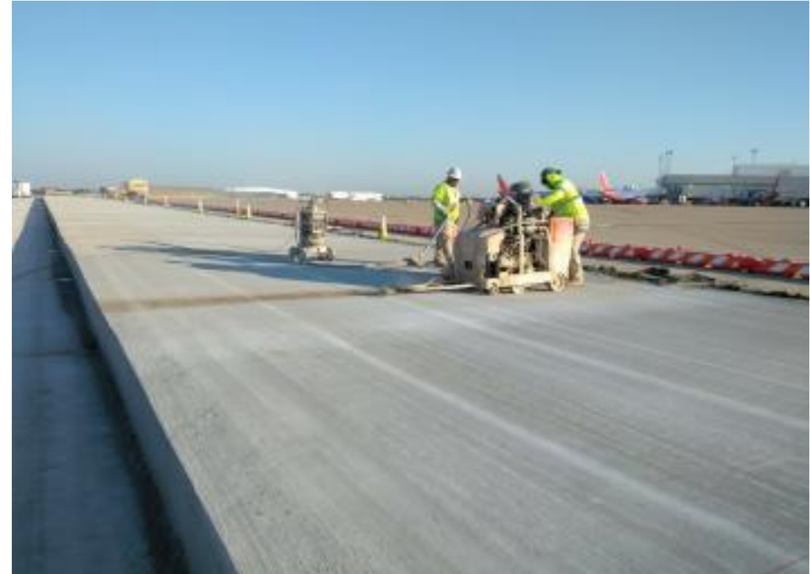
Figura 6 - TWY C, capa de pavimento final instalada, corte de sierra en curso
