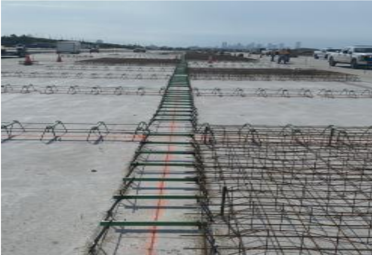
Figura 5 - TWY C con reforcimientos colocados en preparación para la capa final de pavimento
