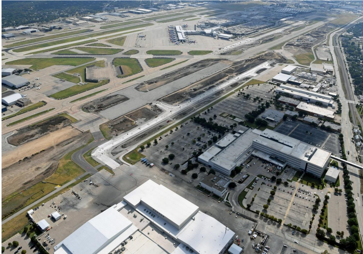
Figura 3 - Nuevo TWY T en construcción (Fase 1) y mitad norte de RWY 13R/31L en construcción (Fase 2)
