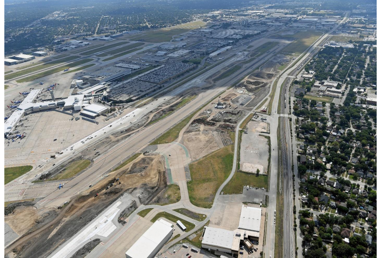
Figura 2 - RWY 13R/31L y TWY C en construcción
