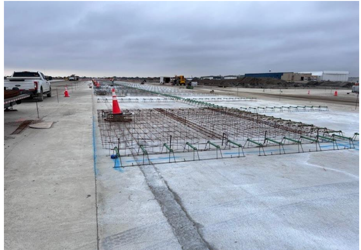
Figura 6 - RWY 13R/31L, preparación de la capa final del pavimento
