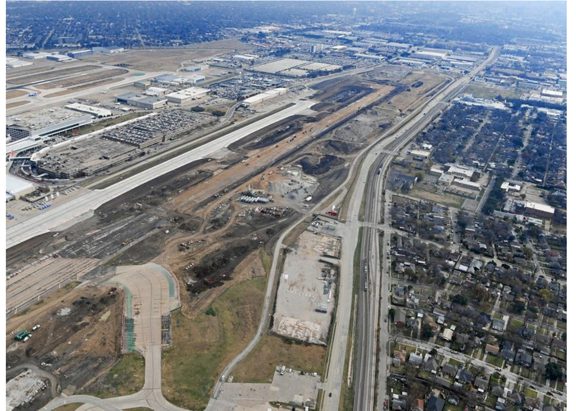
Figura 4 - TWY C en funcionamiento
