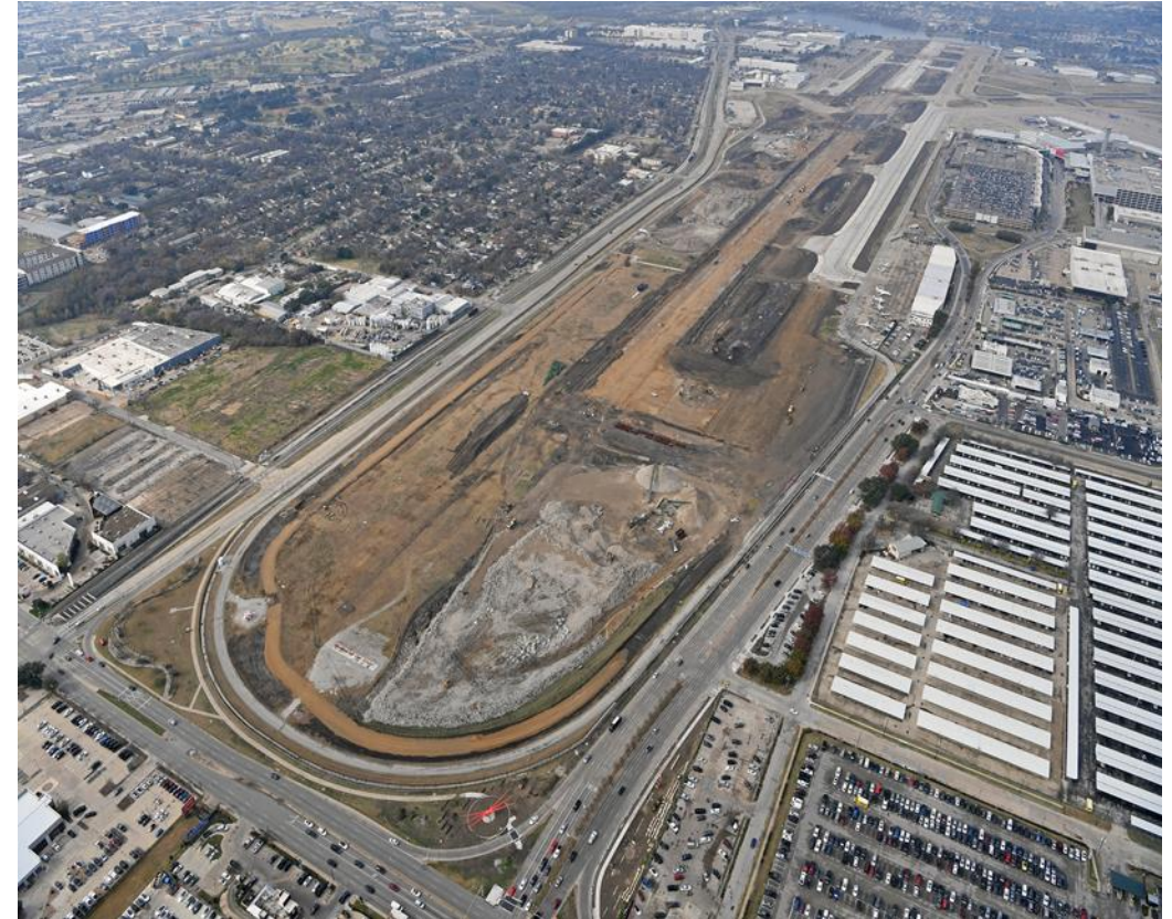
Figura 2 - RWY 13R/31L y TWY C en construcción
