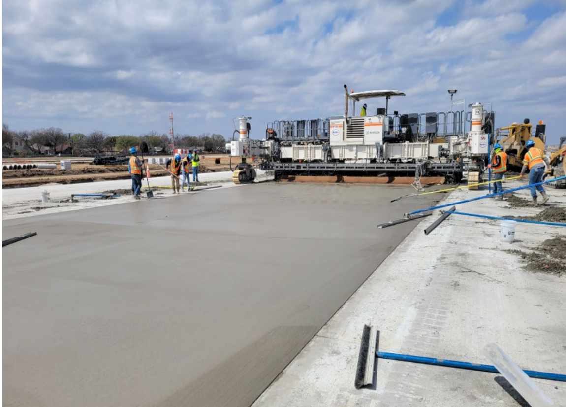
Figura 6 – RWY 13R/31L con refuerzos y colocación de la capa final del pavimento de hormigón
