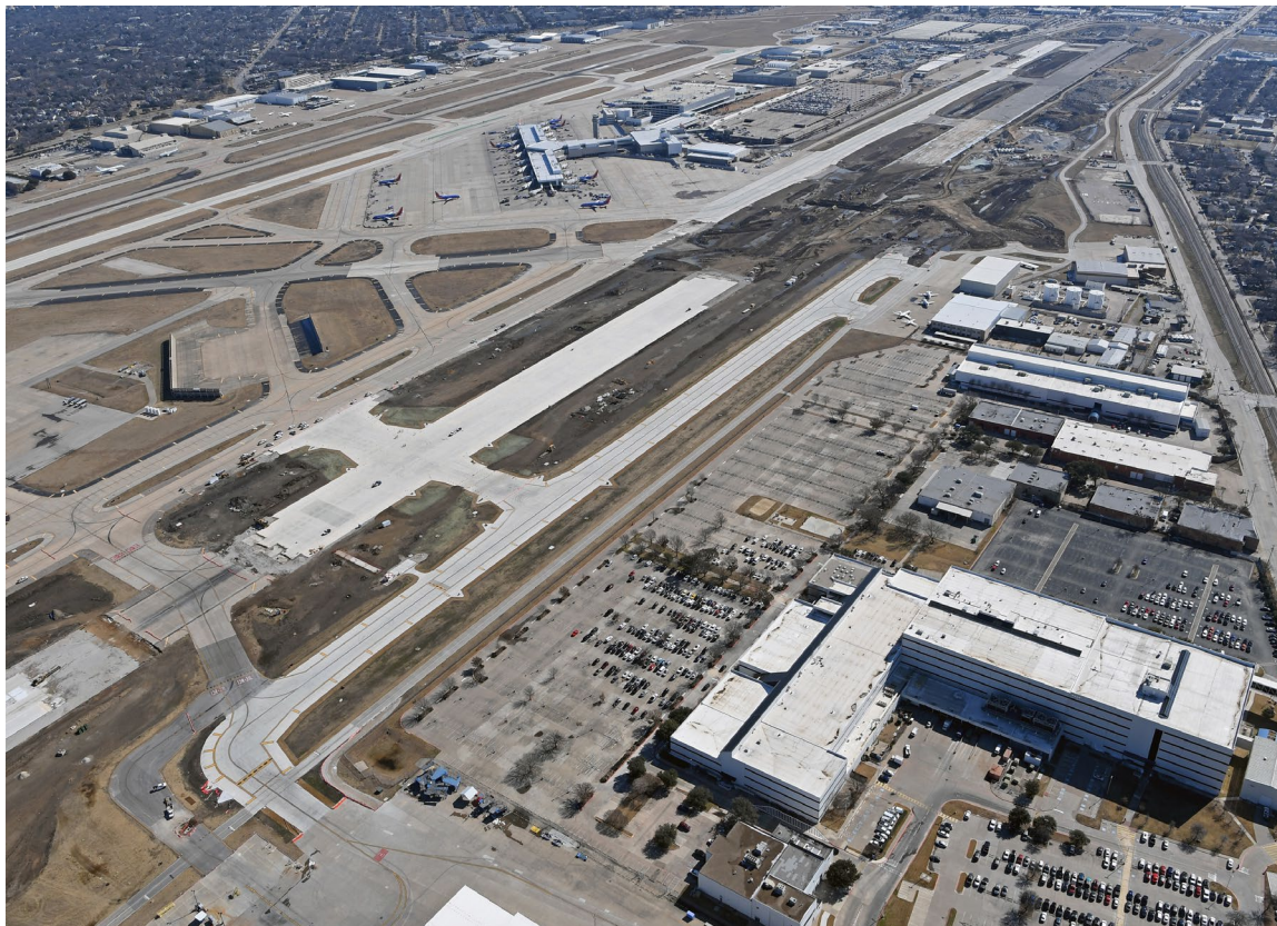
Figura 3 - Nueva TWY T, TWY T 5, y TWY C 7 en funcionamiento
