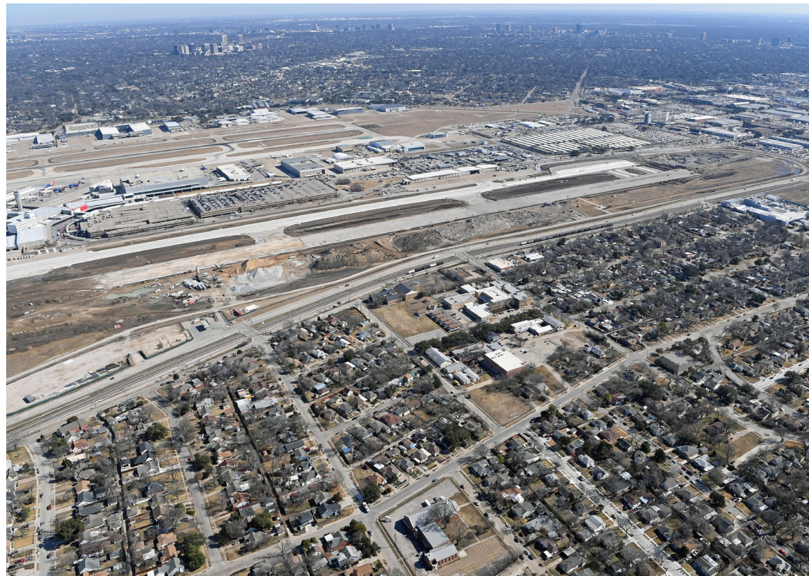
Figura 4 - TWY C en funcionamiento
