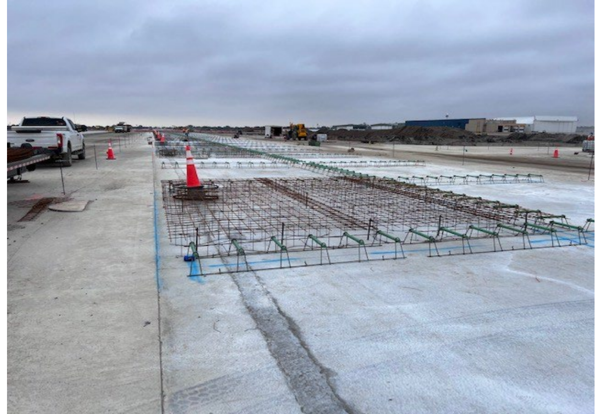
Figura 7 – RWY 13R/31L, preparación de la capa final del pavimento
